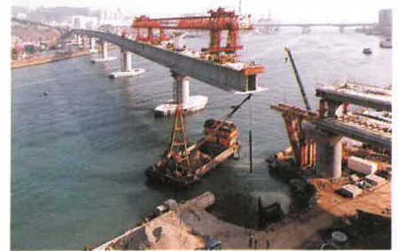
Rambler Channel Bridge under construction. 建設中的藍巴勒海峽大橋。
